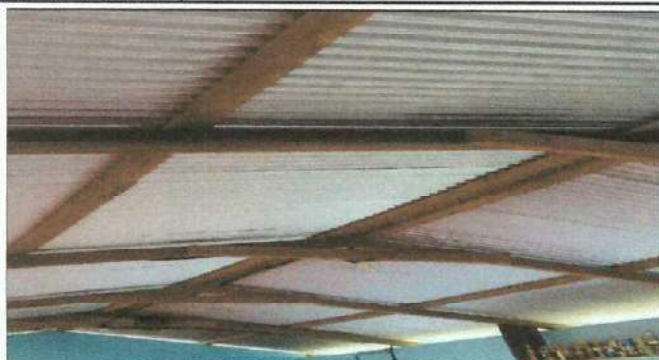
Foto1. Cambio de estructura de techo
