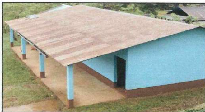
Foto 3: Cambio de cubierta de techo
