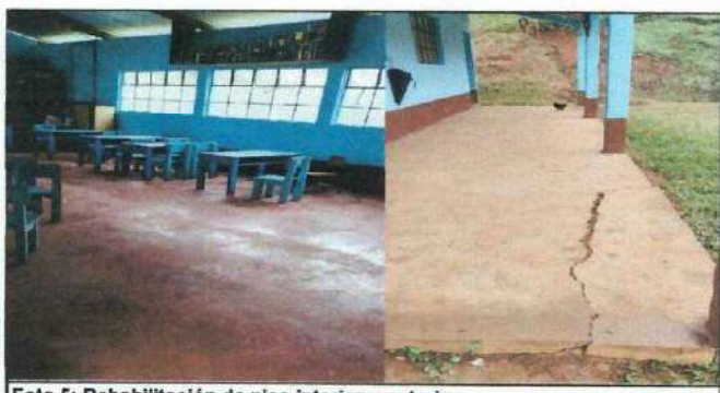
Foto 5: Rehabilitación de piso interior y exterior
