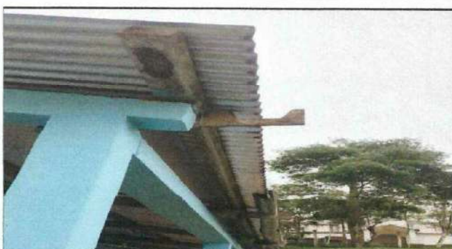
Foto 4: Sustitución de canales
