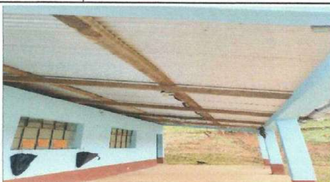
Foto 2: Cambio de cubierta de techo del corredor del establecimiento
